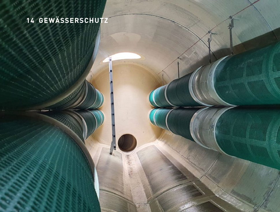
Gute Gelegenheit: Im Zuge der Bauarbeiten an der Volbedingstraße wagen die Leipziger Wasserwerke den Pilotversuch und verbauen einen neuartigen Regenüberlauf.
