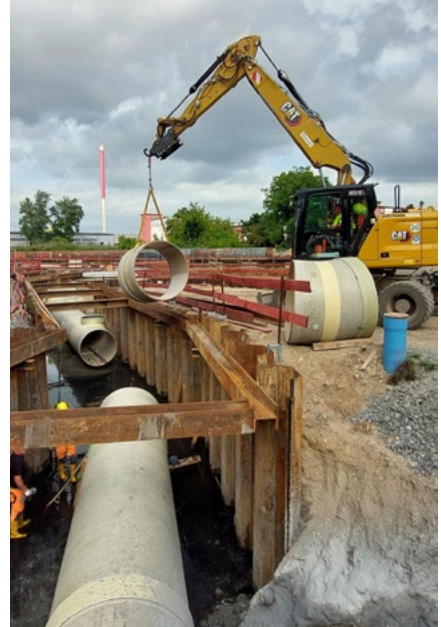
Gute Gelegenheit: Im Zuge der Bauarbeiten an der Volbedingstraße wagen die Leipziger Wasserwerke den Pilotversuch und verbauen einen neuartigen Regenüberlauf.
