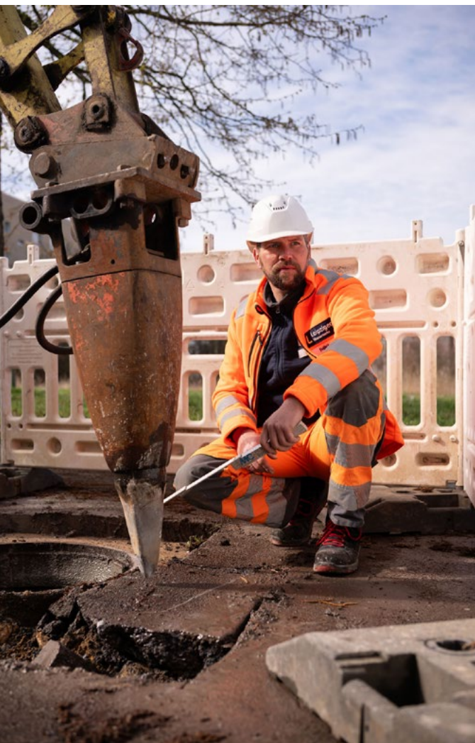
Mit dem Minibagger arbeitet sich Eric Fröhlich zum Abwasserkanal vor.
