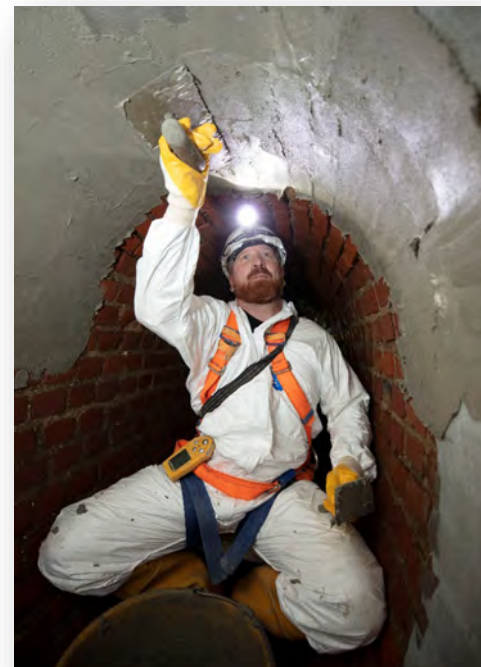
Händische Kanalsanierung
