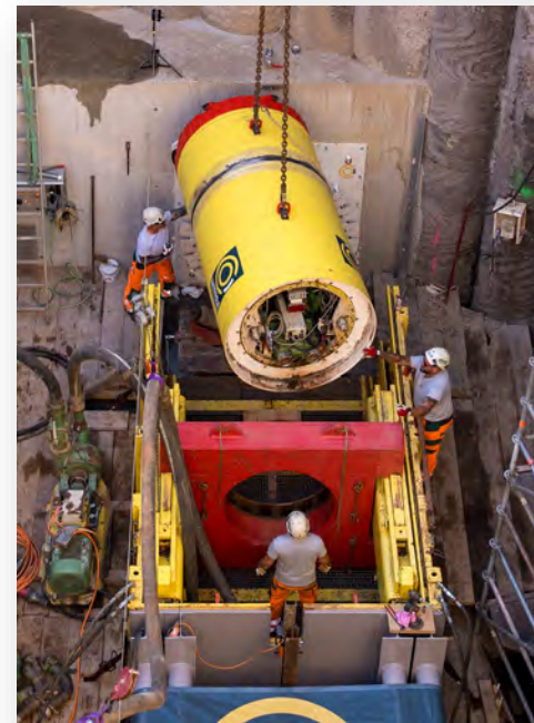
Dükerneubau mit Tunnelbohrung
