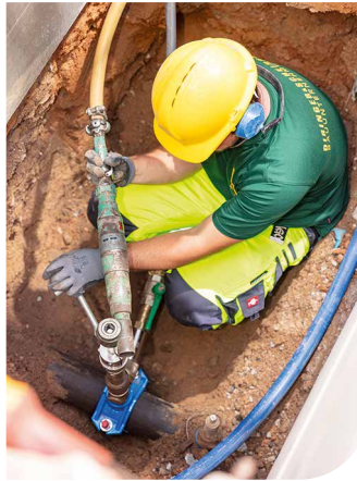
Die Wasserwerke erneuern die Hausanschlüsse
