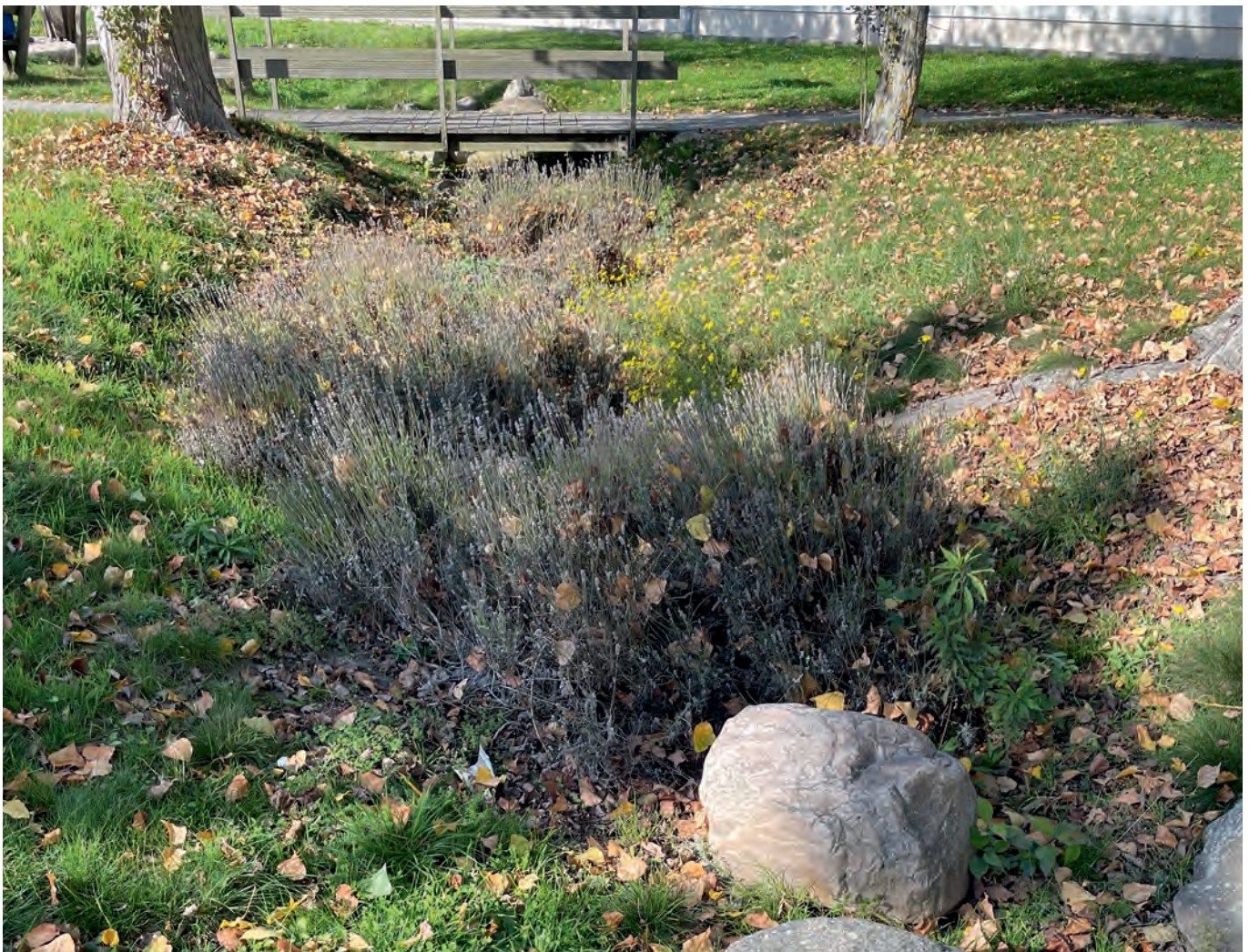
Abbildung 17: Bepflanzte Entwässerungsmulde (Leipzig, Probstheida)
