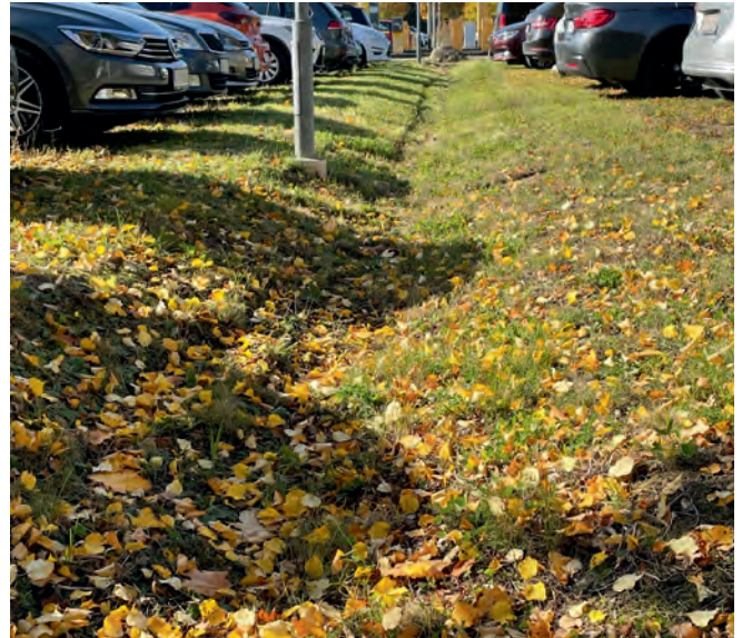
Abbildung 34: Entwässerungsmulde für einen Parkplatz
