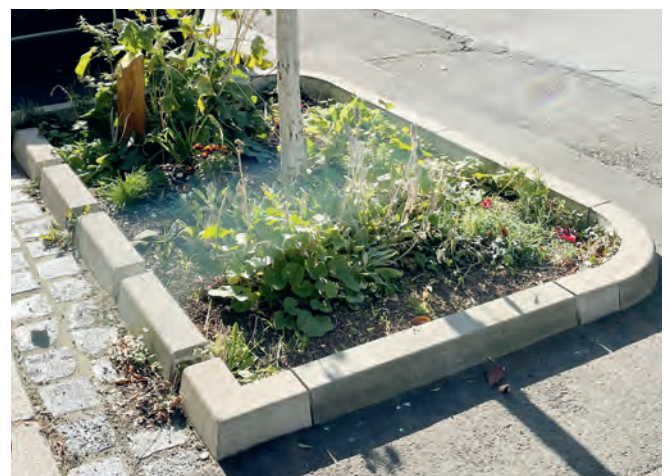
Abbildung 20: Baumrigolen mit Einlaufschlitzen in der Kochstraße, Leipzig
