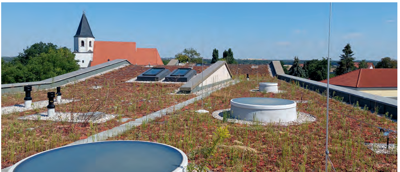
Abbildung 23: Retentionsgründach der Grundschule Dölzig
