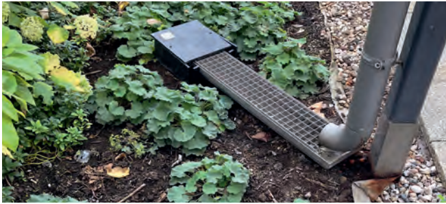
Abbildung 39: Beispiel eines Zulaufs in eine Versickerungsanlage
