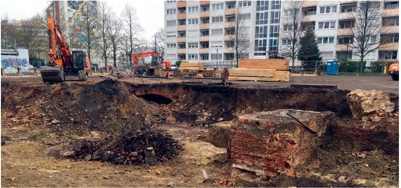
Abbildung 27: Auffüllungen und Bebauungsreste im Untergrund (Leipzig, Bernhard-Göring-Straße)
