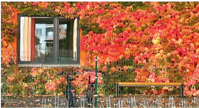
Abbildung 25: Fassadenbegrünung (Leipzig, Hohe Straße)
