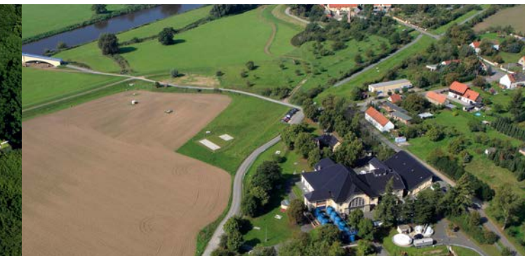
Wasserwerk Canitz mit Rohrbrücke
