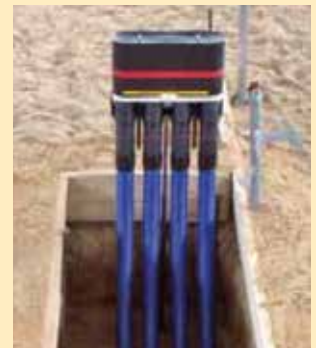
Mehrspartenhauseinführung in ovaler Bauweise
