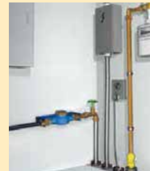
Mehrspartenhauseinführung in ovaler Bauweise
