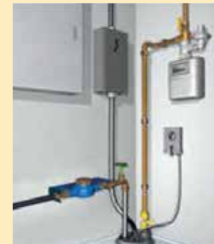
Mehrspartenhauseinführung in runder Bauweise
