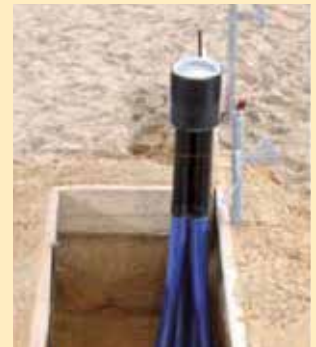
Mehrspartenhauseinführung in runder Bauweise
